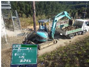
積込状況写真
