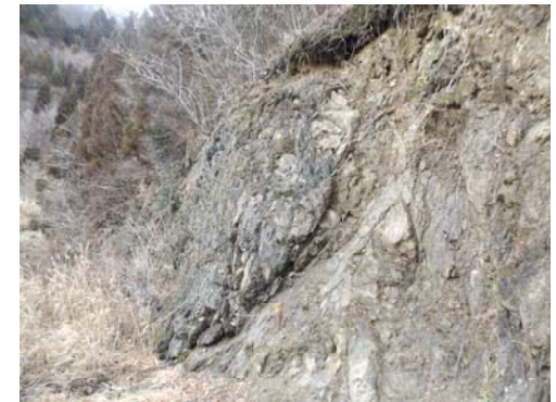
▲現地踏査写真（塊状蛇紋岩：遠景）
