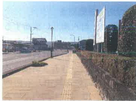
図 広幅員がとられた歩道
