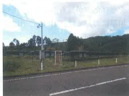
図 沿道から見える太陽光発電設備
