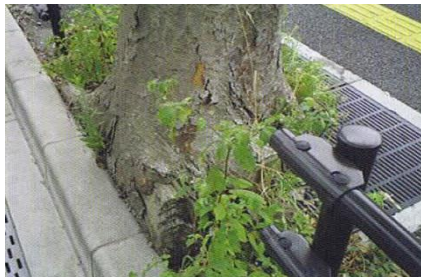
植樹スペースが狭く根が変形、削り取られた樹木
