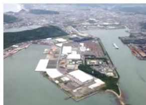
日向市に国産材としては国内最大級の製材工場が進出
