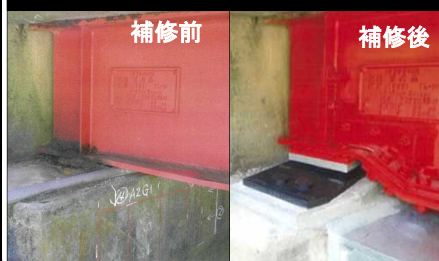
橋梁の老朽化対策（支承取替）
