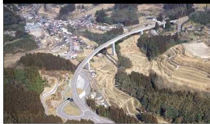
中山間地域の道路整備
