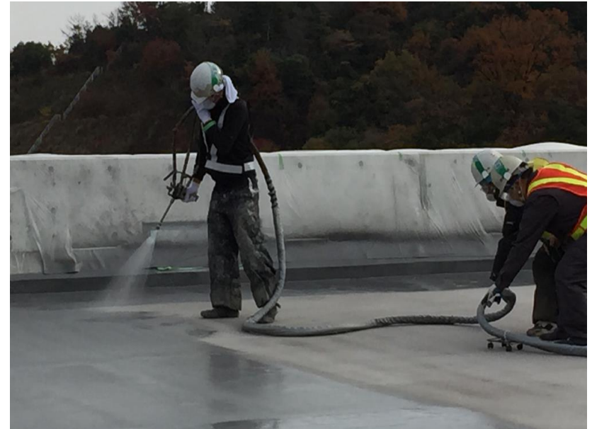
防水層施工状況
