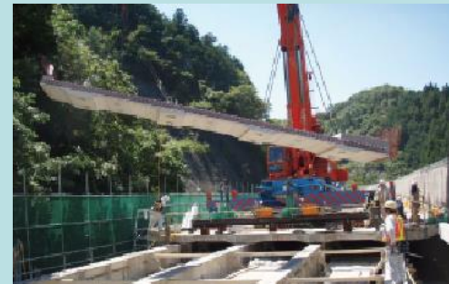
床版取替工事一例
