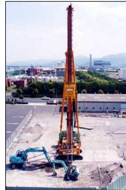
スラリー攪拌工
