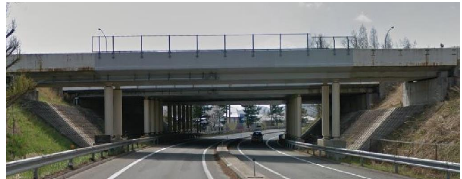
ロッキング橋脚を有する橋梁
