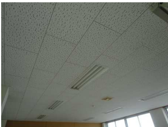
雨漏り跡なし 3階その他天井も同様
