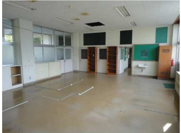
空調設備（パッケージエアコン）取り外し済み 全棟
